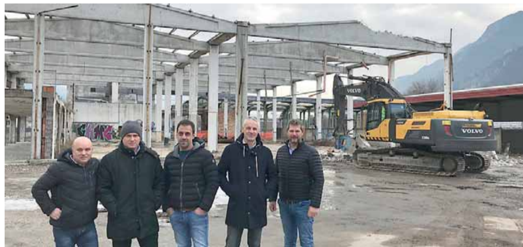
Soci, tecnici e il progettista del gruppo Mak ieri al cantiere di via Brennero per festeggiare l'inizio della demolizione
